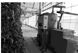
間伐材を使ったペレットボイラーによるハウス加温
