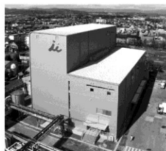
複合冷凍施設
