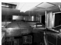
①蒸機&熱回収用フィンコイル
