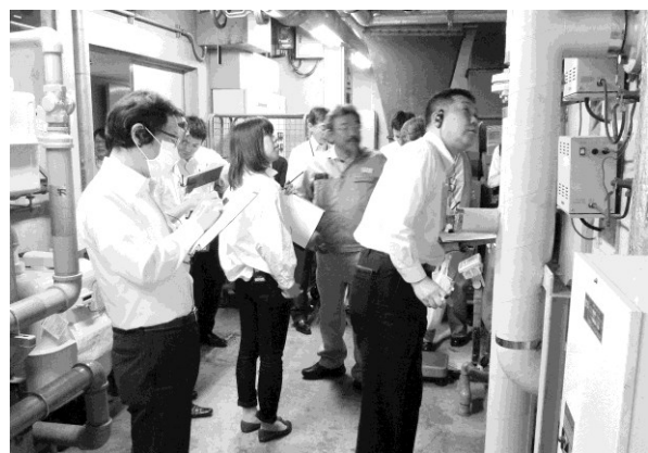
国分本社ビルの設備をウォークスルー
