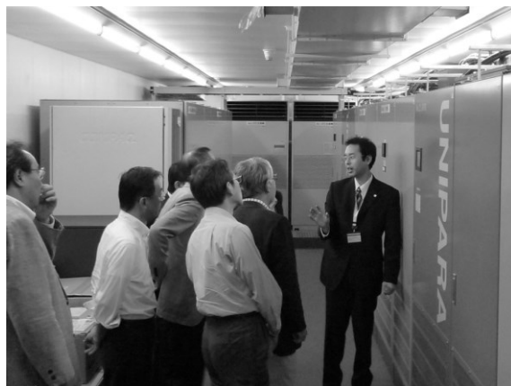
(株)サイバーリンクス社データセンター見学
