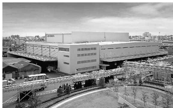
味の素(株) 川崎物流センター
