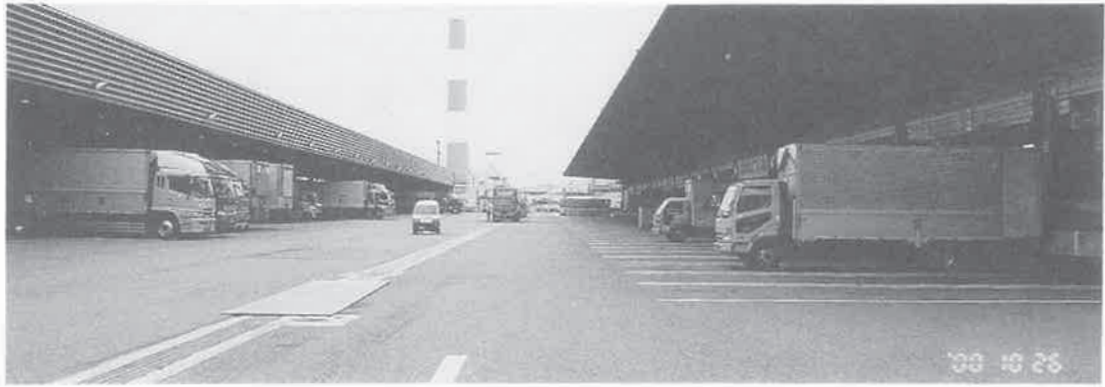
広大なトラックヤード
